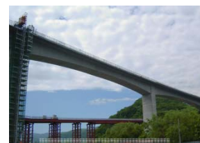
現場見学 「朝里川橋」
