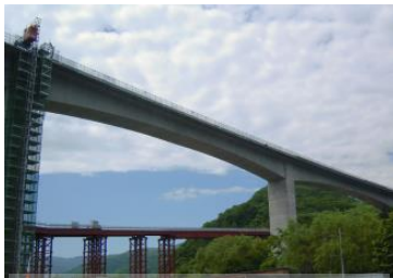
現場見学「朝里川橋」
