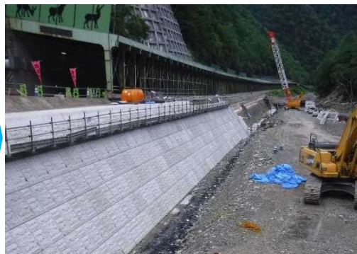
覆道基礎の復旧完了 (H29.8.1撮影)
