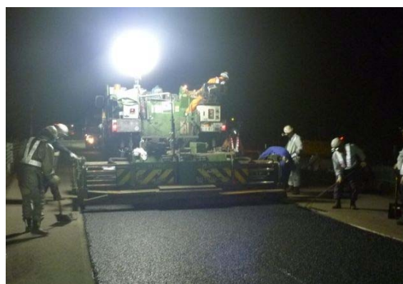
＜舗装補修状況＞
