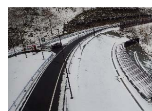
復旧工事完了
