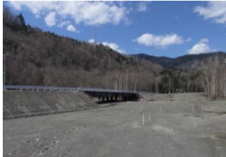
仮橋架設完了
