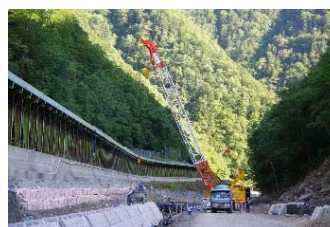
基礎復旧工事完了
