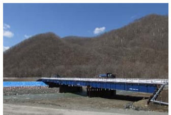
仮橋架設完了
