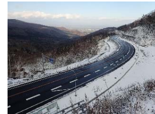
復旧工事完了
