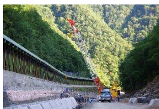
基礎復旧工事完了
