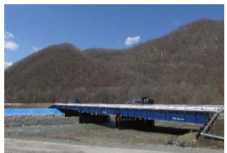
仮橋架設完了
