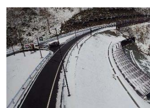
復旧工事完了
