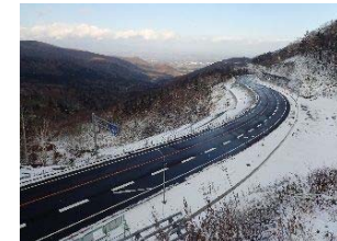
復旧工事完了
