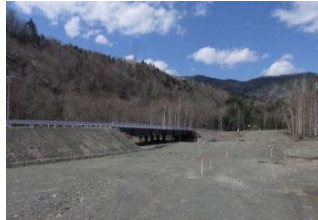
仮橋架設完了
