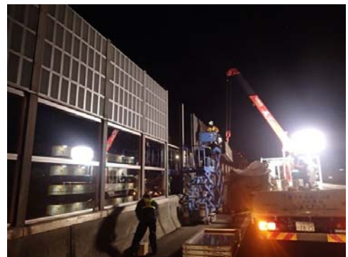
＜遮音壁補修状況＞
