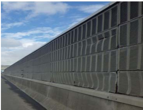
＜遮音壁損傷状況＞
