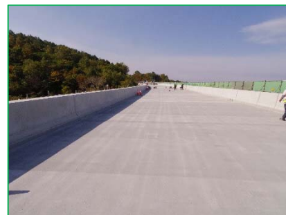
【新設コンクリート床版施工完了】
