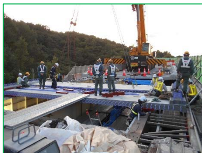
【新設コンクリート床版の設置】
