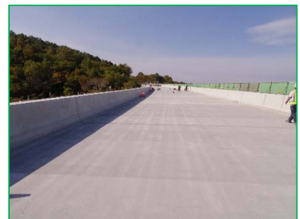
【新設コンクリート床版施工完了】
