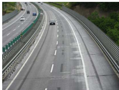
【舗装路面の損傷状況(島松川橋)】
