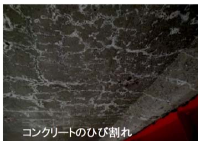
【床版裏面のコンクリートはく離発生状況(島松川橋)】
