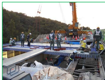
【新設コンクリート床版の設置】
