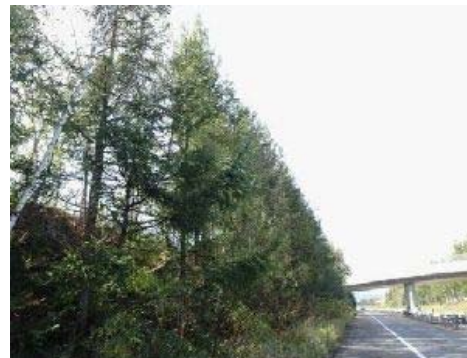
<植栽繁茂状況>
