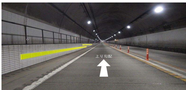
トンネル内の水平ライン
