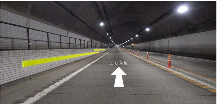
トンネル内の水平ライン
