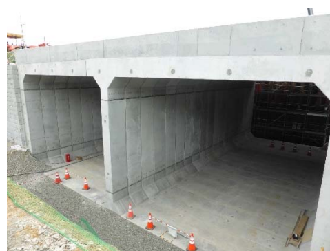
小樽方向(上り線) 函渠設置状況
