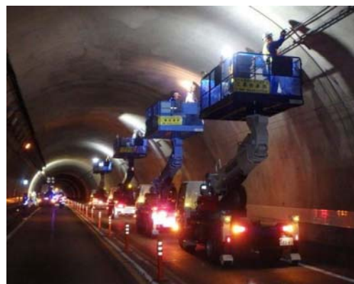
<トンネル照明取替工事>
