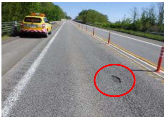
<路面補修箇所>
