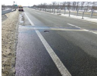
【路面の損傷発生状況(勇払川橋 下り線)】
