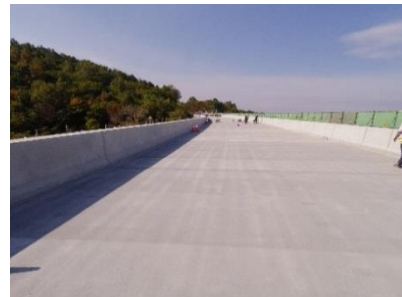
【新設コンクリート床版施工完了】
