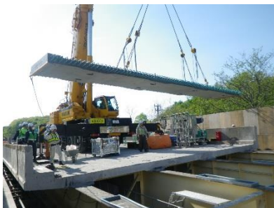
【新設コンクリート床版の設置】
