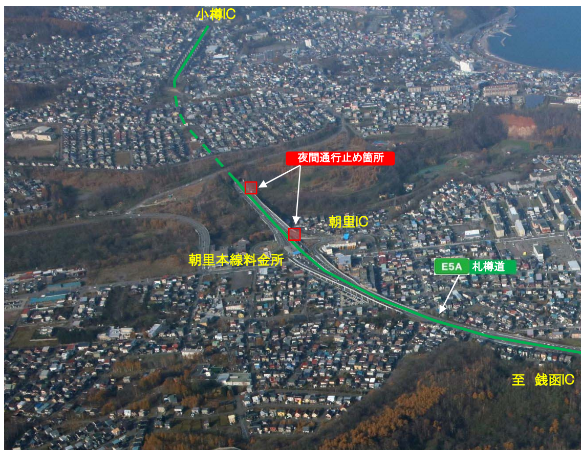
朝里本線料金所付近 航空写真(全景)
