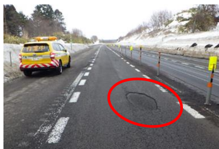
路面損傷例
