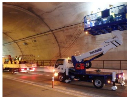
トンネル照明更新工事例
