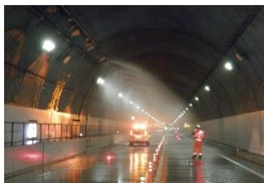
トンネル設備(防火設備)点検例
