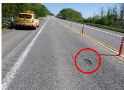
路面損傷例
