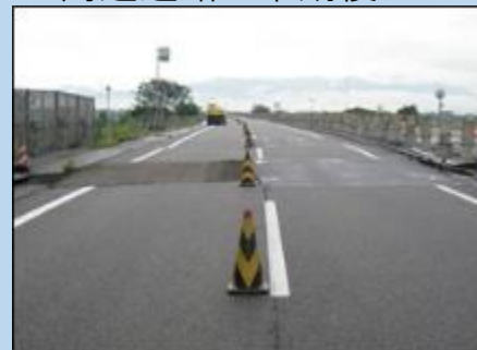
高速道路の早期復旧
