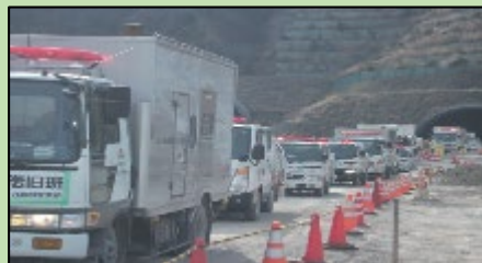
緊急開口部の活用
