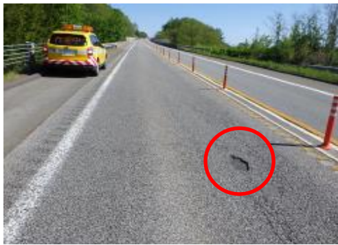
路面損傷例
