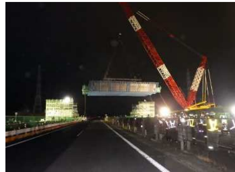
IC新設工事 橋梁架設(イメージ)
