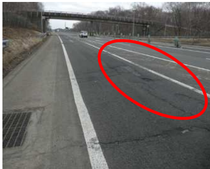
路面損傷例
