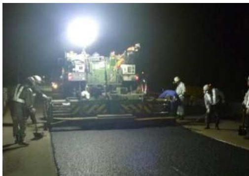
路面補修工事例
