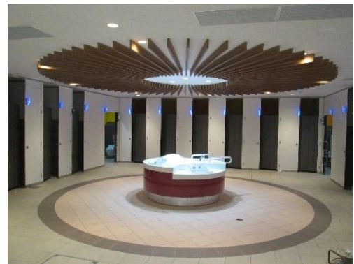
女性用トイレ 改修後
