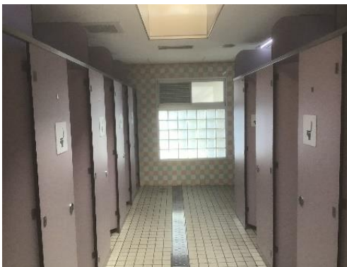
女性用トイレ 改修前
