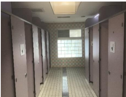
女性用トイレ 改修前
