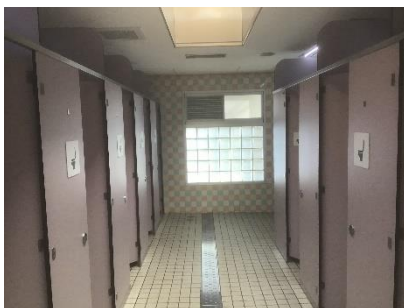
女性用トイレ 改修前
