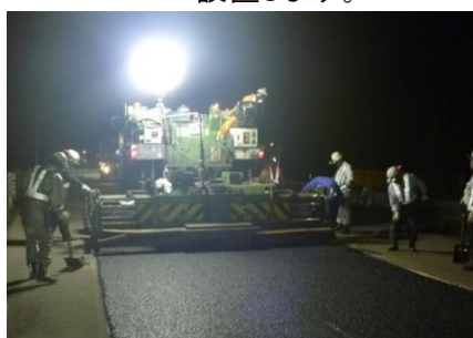
路面補修工事例
