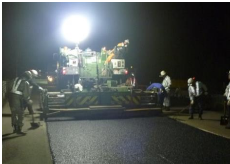
路面補修工事例
