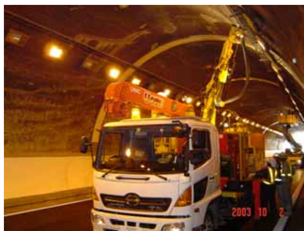
PVMシステムによるトンネル空洞調査状況
