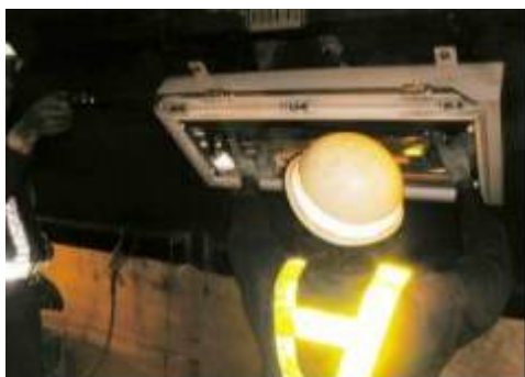
トンネル照明設備清掃・点検
