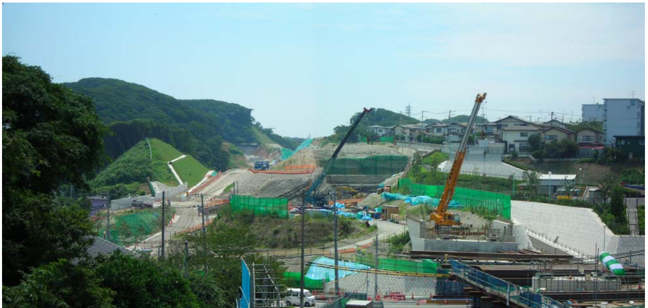
横須賀市桜ヶ丘付近の施工状況（馬堀IC（仮称））
