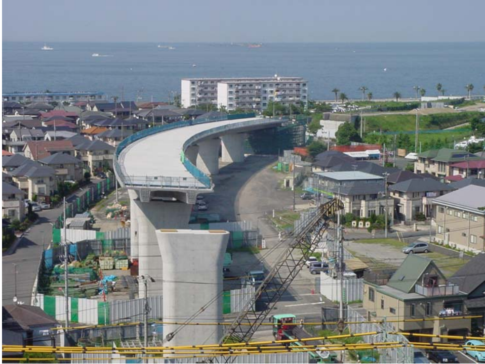
横須賀市馬堀海岸付近の施工状況
