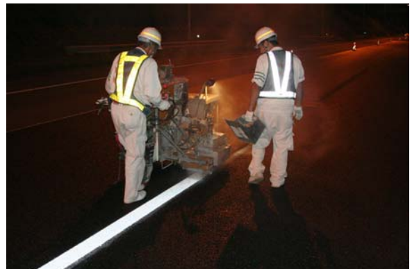
路面標示作業
