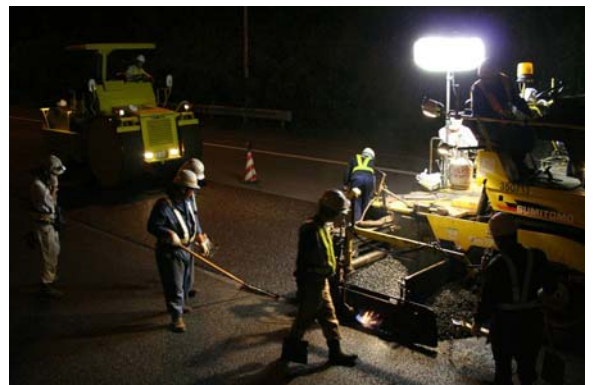
新設アスファルトの敷き均し作業
