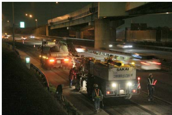
既設舗装路面の切削作業
