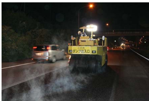
新設アスファルトの転圧作業
