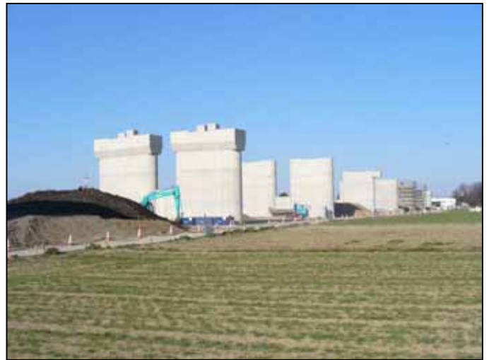
写真 (桶川JCT (仮称) 方面)
