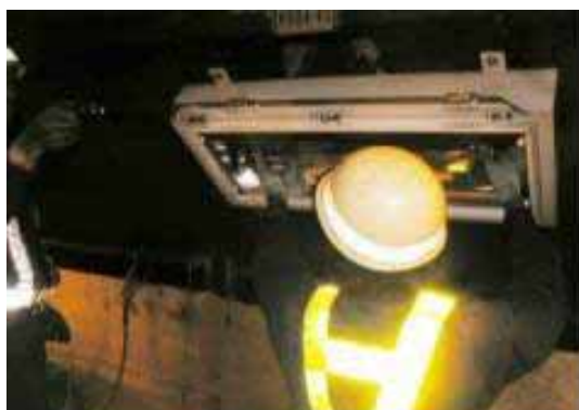
トンネル照明設備清掃・点検
