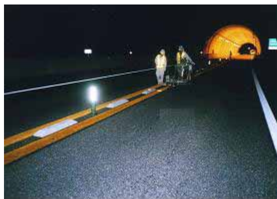
路面標示工の設置
