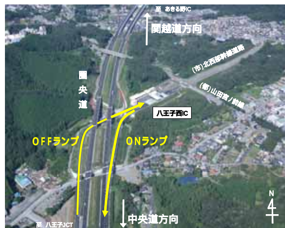
【八王子西インターチェンジの状況】 〔中央道方向のみ出入り可能なハーフインターチェンジ〕
