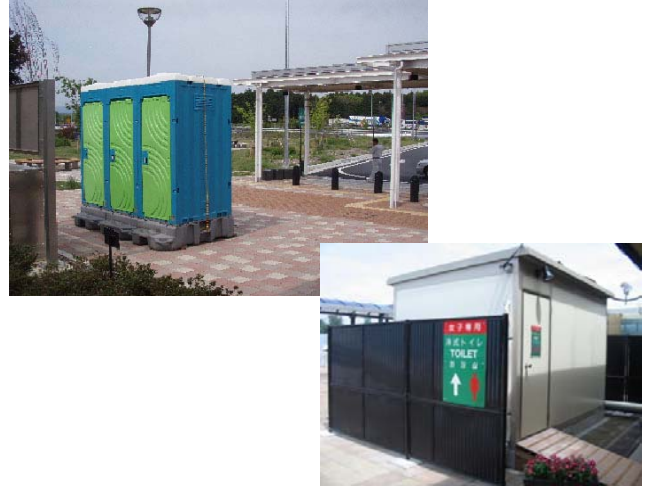
仮設トイレの設置
