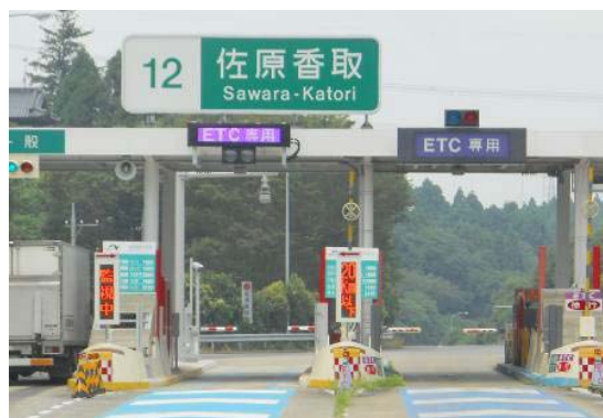
増設されたETCレーン 左ETCレーン: 増設後のLED表示 右ETCレーン: 従来からの内照式.
