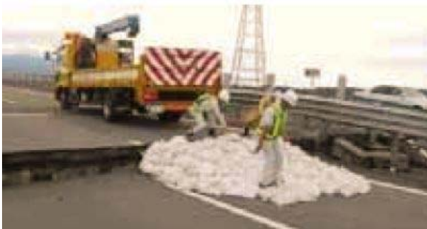
災害時の応急復旧
