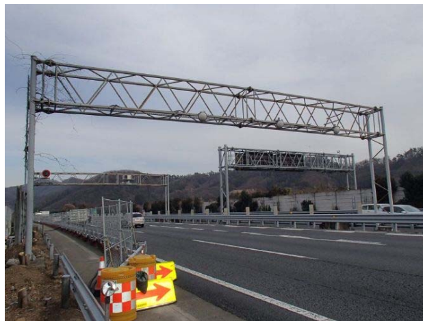
今回撤去する門型標識支柱
