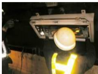
トンネル照明設備清掃・点検
