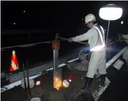
防護柵の取替え
