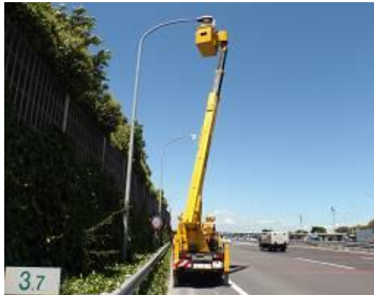
道路照明の点検
