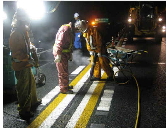
路面標示の改良
