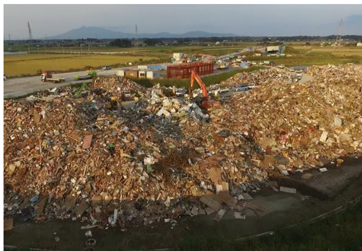
○災害で不要となった廃棄物等の 受け入れ状況（常総IC）（10月4日撮影）
