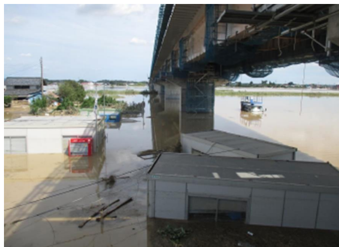
○工事現場内の浸水状況 （9月11日撮影）
