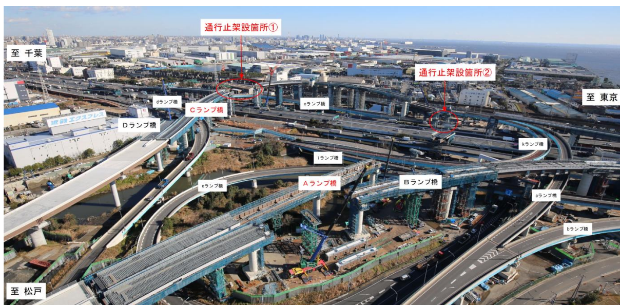
高谷ジャンクション(仮称) 工事状況(全景)
