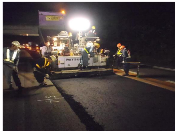
舗装補修工事
