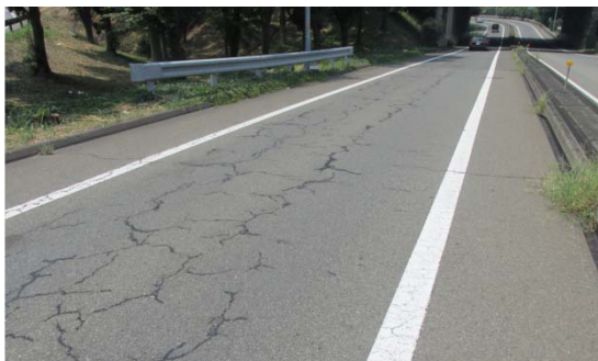
東松山IC 現況舗装状況
