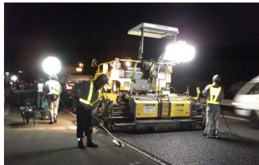
夜間舗設作業
