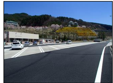
舗装改良(駐車場)
