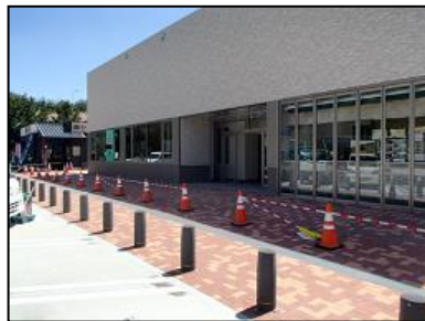
駐車場と歩道部のバリアフリー化
