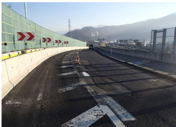
更埴JCT連絡路 現況舗装状況
