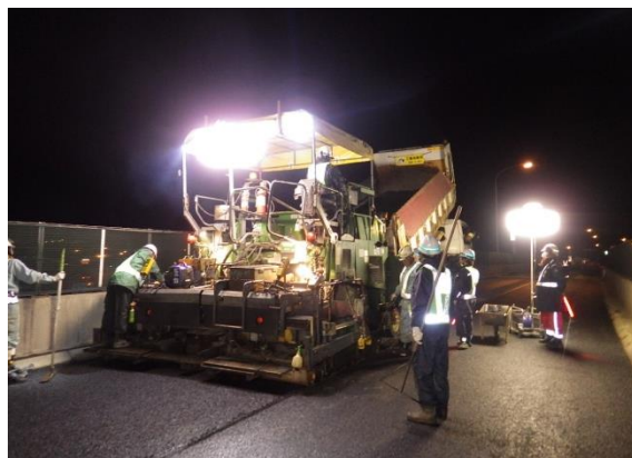
夜間舗設作業
