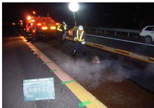
舗装路面の補修
