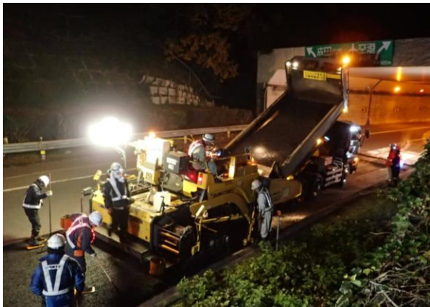
舗装補修工事①
