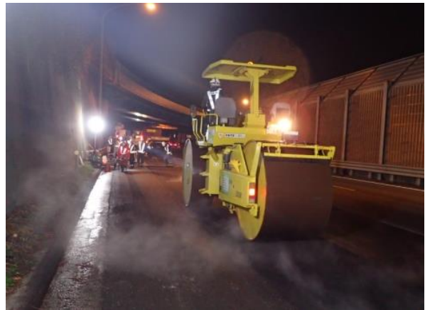
舗装補修工事②
