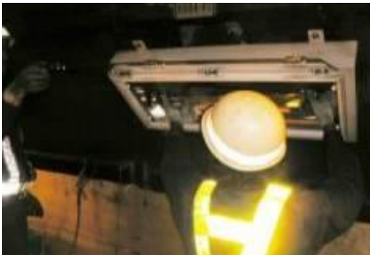
トンネル照明設備清掃・点検
