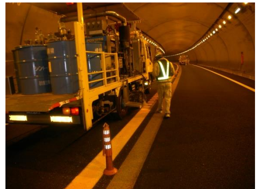
路面標示工の実施
