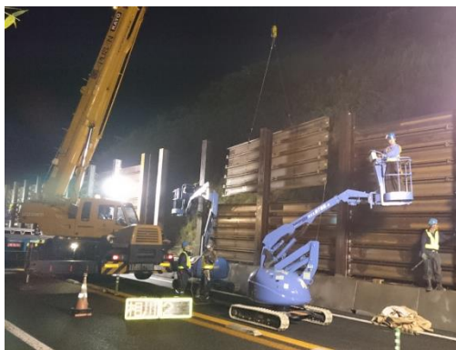
落石防護柵の設置(通行止め時作業)
