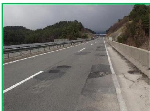
【舗装路面損傷状況(小仁熊橋)】
