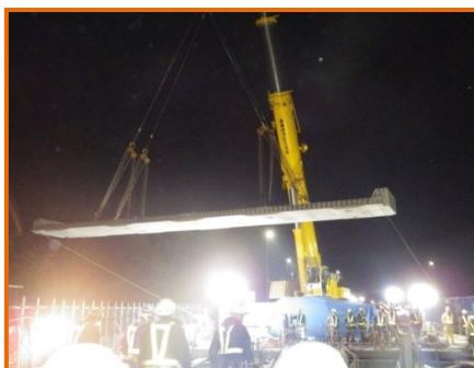
【新設コンクリート床版の設置※】
