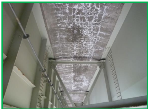
【コンクリート床版裏面ひび割れ状況(小仁熊橋)】
