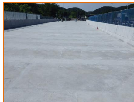
【新設コンクリート床版施工完了※】
