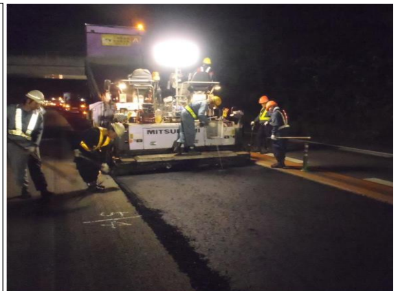
舗装補修工事
