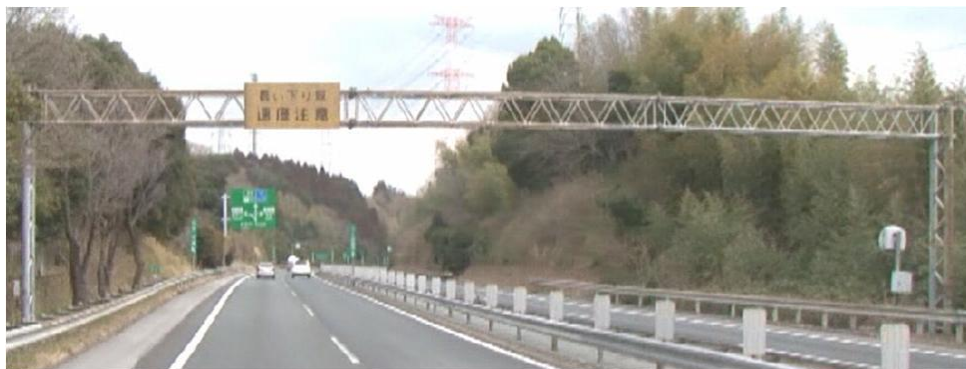
老朽化した門型柱の撤去
